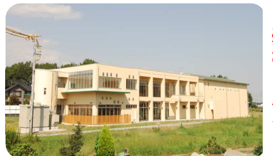
同センターの視察が10月に行われ、今年度、外構工事や前面道路の一部整備を行うとのことです。
