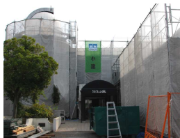
こどもの城の改修中
